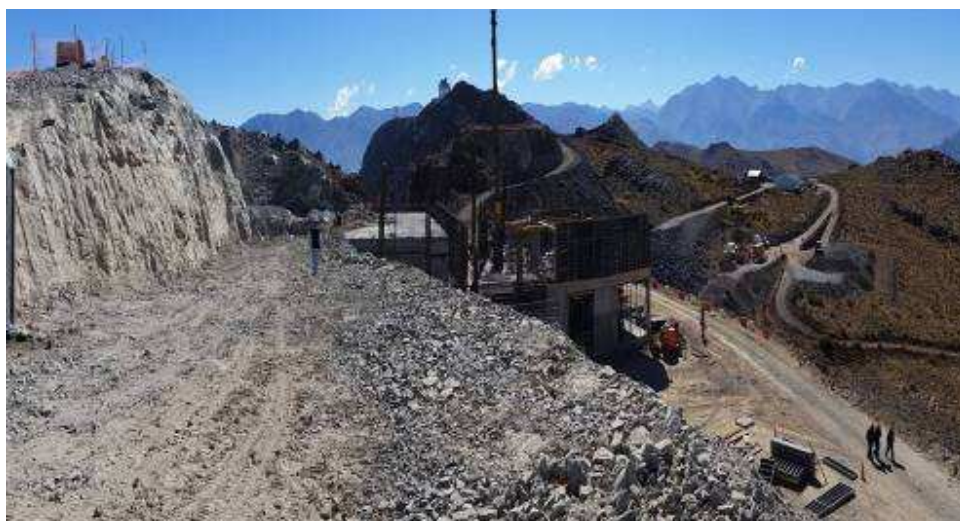
Figura 4.11 – Obras para a construção do prédio que irá abrigar o LSST.
